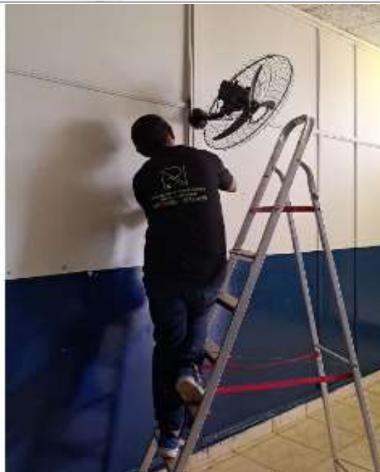
Troca de fiação, reposição de tomadas novas, foi embutida toda a fiação.
