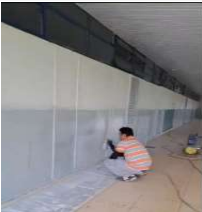
Pintura de toda a instituição interna e externa
