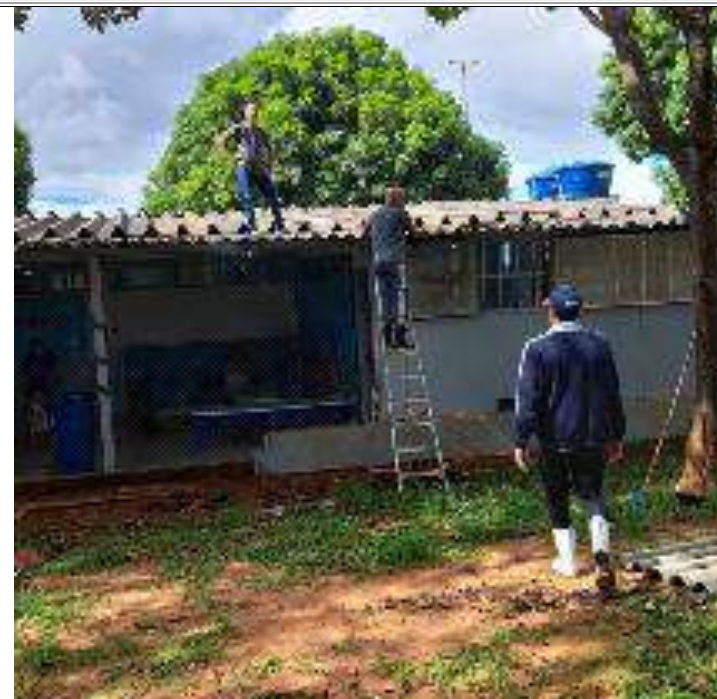
Reforma do telhado (troca de telhas)
